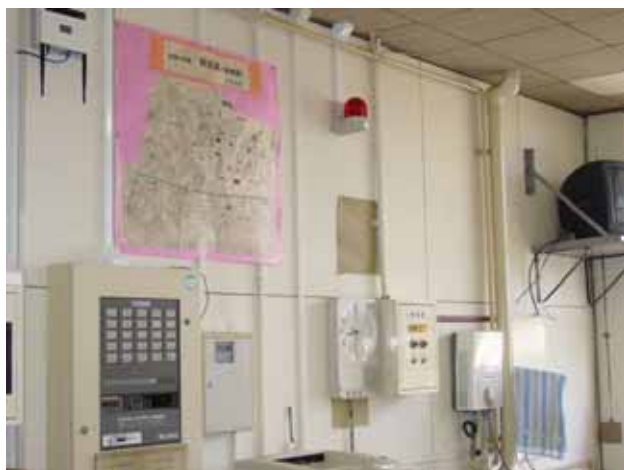
下：職員室に取り付けられたブザー内蔵回転灯
