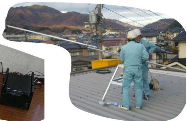
本部側 建物の屋上にアンテナを設置(屋上高5m) 制御卓と無線機は、屋内に設置
