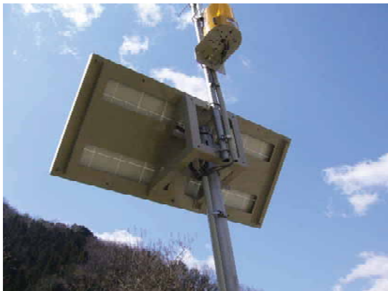
φ89鋼管柱 地上高4mの施工例
